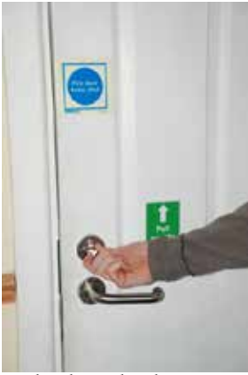
fire door lock unlock.jpg
